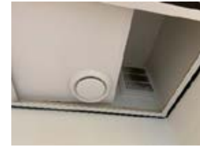
Het mechanisch ventiel belemmert de doorvoer naar het natuurlijke afvoerpunt.
