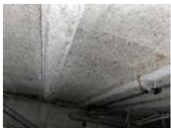
Een poreuze balken-broodjesvloer
